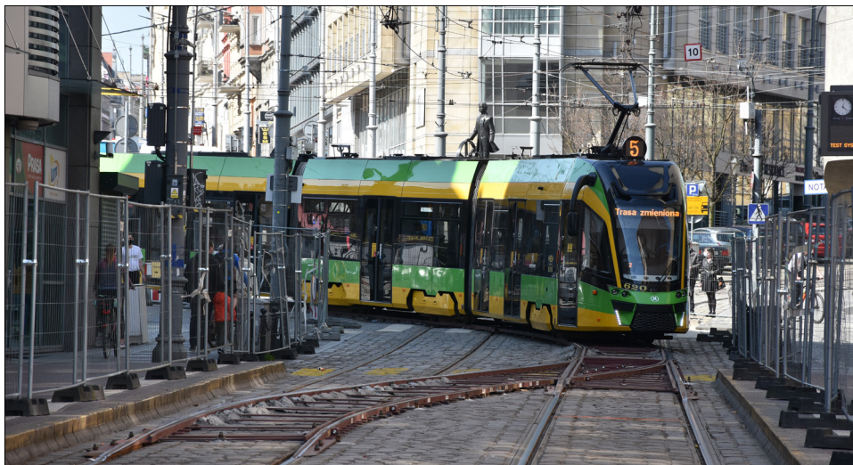
Rysunek 4.18. Przejazd tramwaju łukiem torowiska tymczasowego
