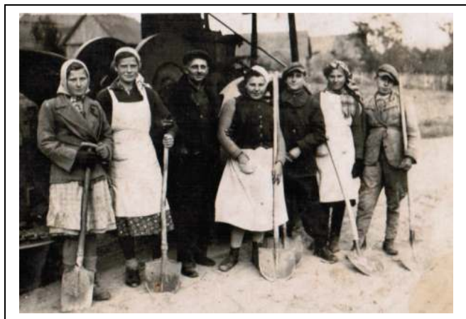
Mieszkańcy gminy podczas przymusowej pracy w niemieckiej Firmie „Deimler” przy budowie drogi Sandomierz – Koprzywnica. 21.10.1940 r. Druga z lewej Helena Jędrzejewska, w środku Maria Gara. Fot. ze zbiorów Ewy Ciżyńskiej.
